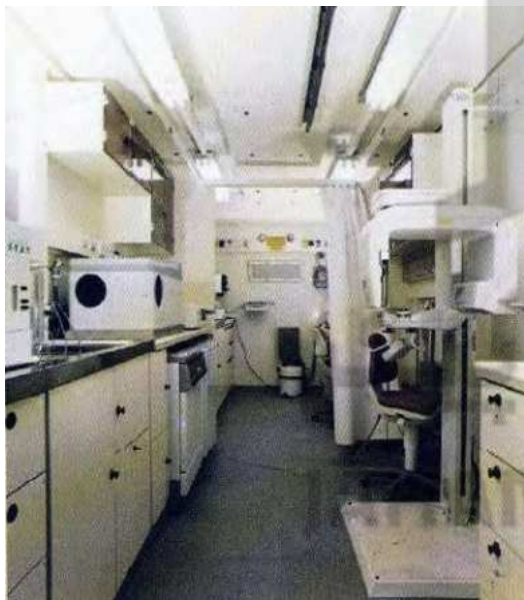
شکل ۲۰-۱ سقف کاذب در یک واحد سیار پزشکی
