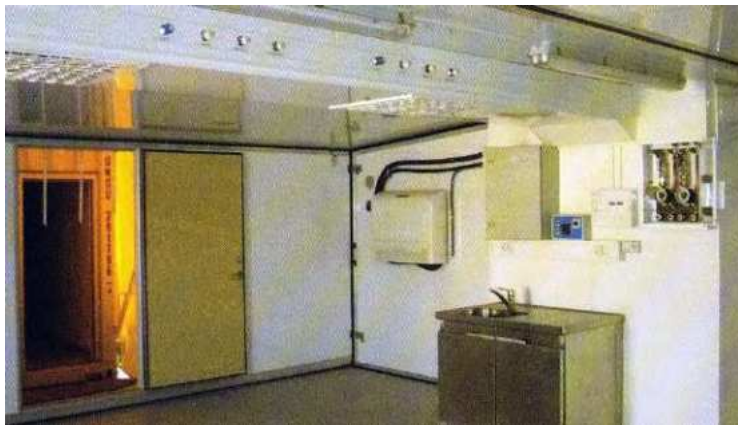
شکل ۲۰-۲ سقف کاذب جهت گذر لوله‌های گاز در اتاق عمل در بیمارستان سیار
